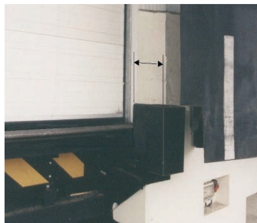
Photo 7.8. Vue sur butoirs assurant un espace de 500 mm devant le mur du quai et devant la rampe ajustable en position de repli.
