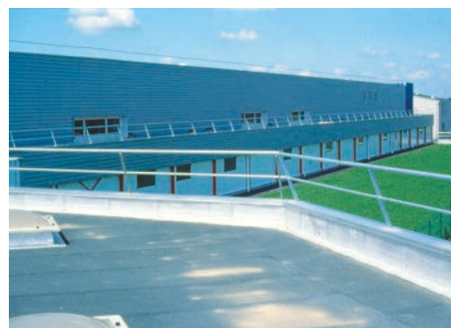
Photo 7.4. Dispositif de garde-corps évitant les chutes en périphérie de toiture.
